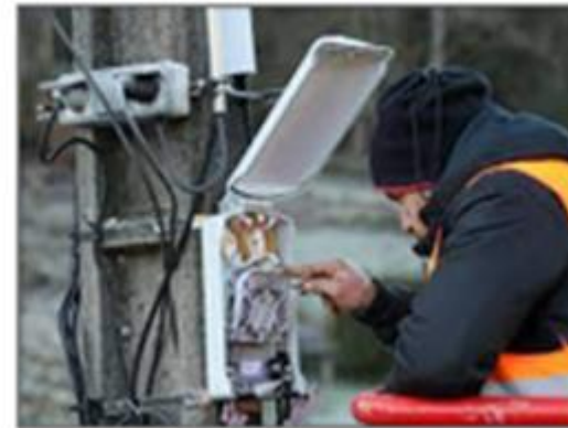
POINT DE BRANCHEMENT OPTIQUE (PBO)
